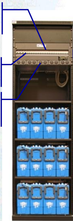
MODULO RECTIFICADOR FMP 25.48 48Vcc - 2500 W - 50A
